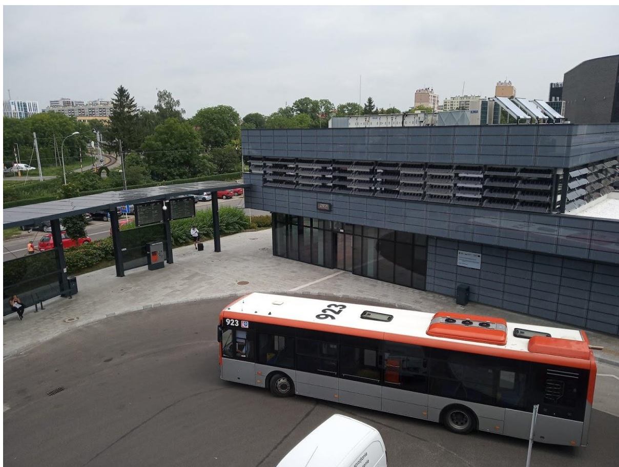
Dworzec Lokalny w Rzeszowie
