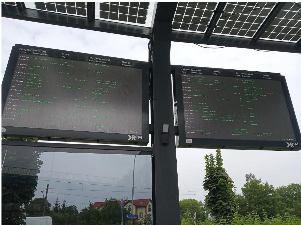
Dworzec Lokalny w Rzeszowie
